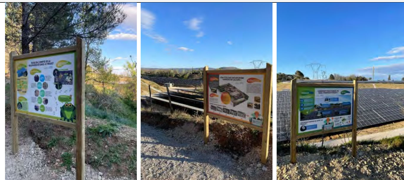
Exemples de panneaux pédagogiques aux abords de la centrale photovoltaïque Montboucher-sur-Jabron (26)
