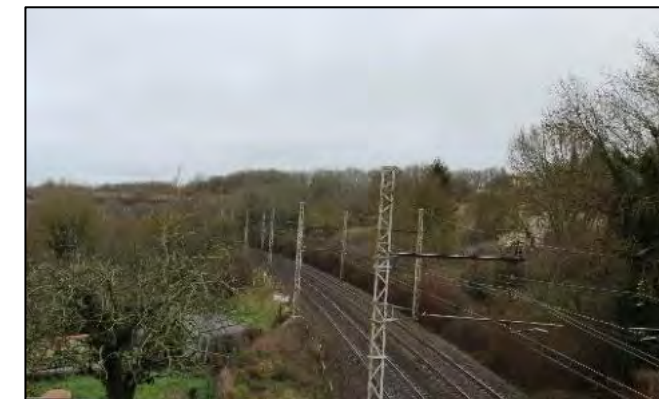
Chemin de fer au Sud du site Source : Artifex 2020
