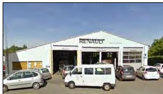
Garage à Mouthiers-sur-Boëme Source : Artifex 2020
