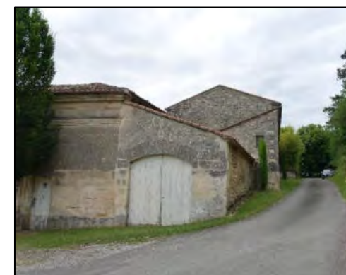
Habitation au lieu-dit « Les Justices » Source : Artifex 2020
