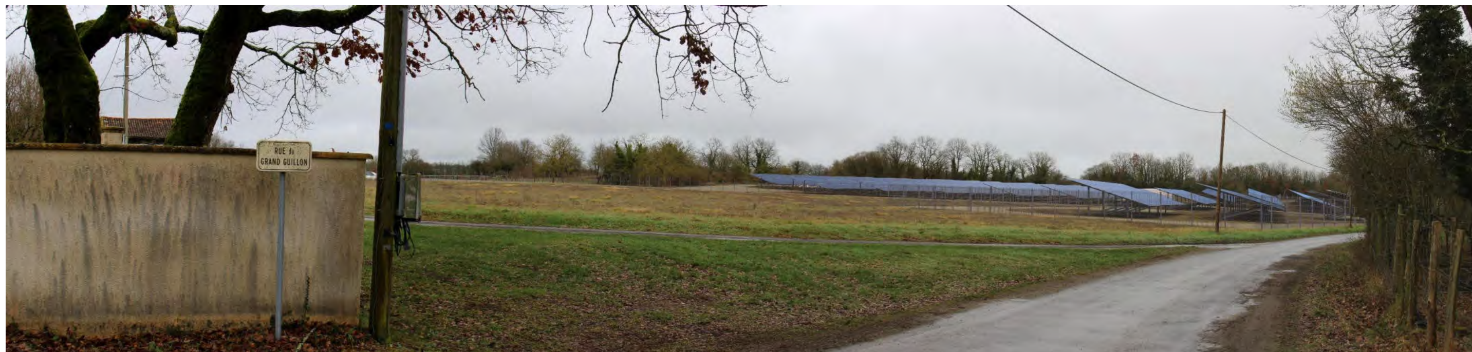
Illustration 3 : Vue depuis les lieux-dits « La Gaillarderie » et « Le Petit Poinaud » - Simulation de principe du projet avant mise en place de la mesure de réduction
