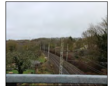
Voie ferrée au Sud du site d'étude Source : Artifex 2020
