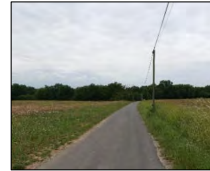
Chemin goudronné carrossable (4) Source : Artifex 2020
