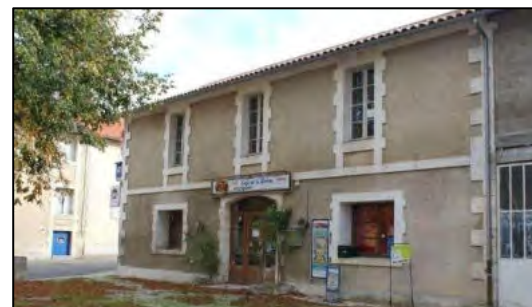
Bar-Restaurant à Mouthiers-sur-Boëme Source : Artifex 2020
