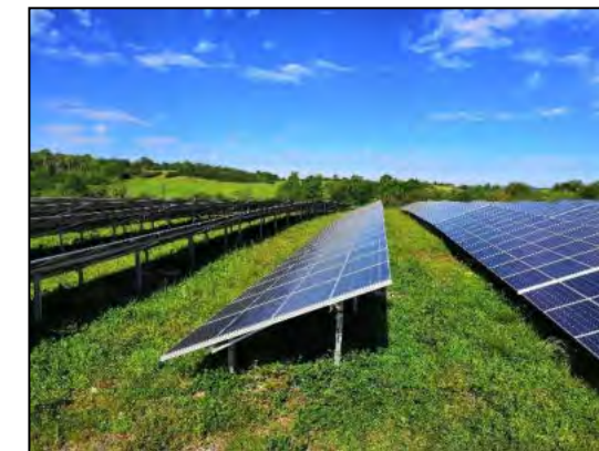
Reprise végétale sous les panneaux photovoltaïques (photo de panneaux sur pieux)
