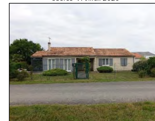
Habitation au lieu-dit « Les Justices » Source : Artifex 2020
