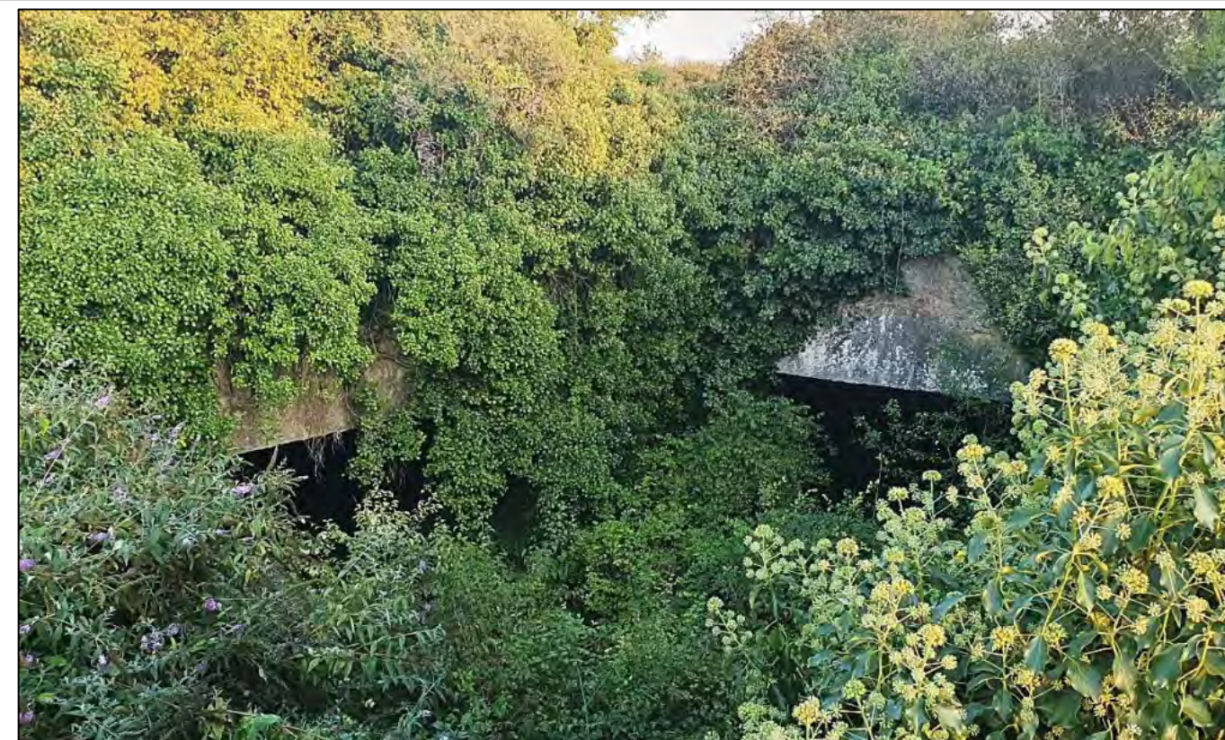
Vue d'ensemble de l'entrée de l'ancienne carrière du Vidaud
