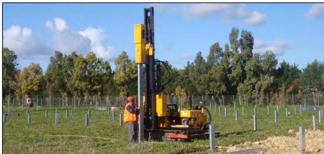
Sonnette de battage hydraulique
