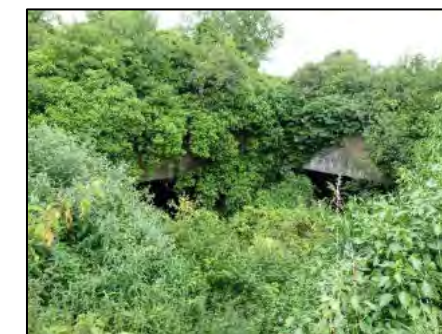
Ancienne carrière souterraine Source : Artifex 2020
