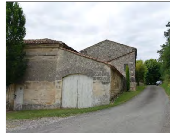
Habitation au lieu-dit « Les Justices » Source : Artifex 2020
