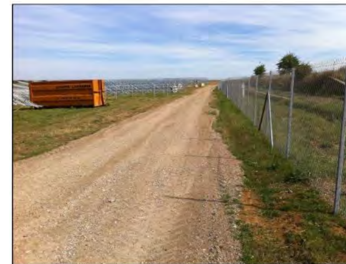
Exemple d'une bande de roulement adaptée aux véhicules lourds Source : TSE
