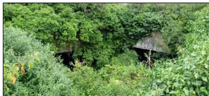
Carrière souterraine « Le Vidaud » sur le site d'étude Source : Artifex 2020
