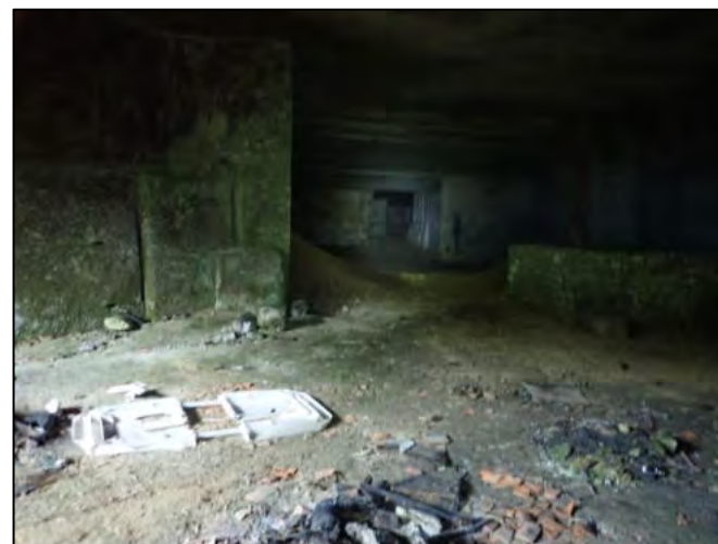
Intérieur de l'ancienne carrière du Vidaud, traces de fréquentation humaine
