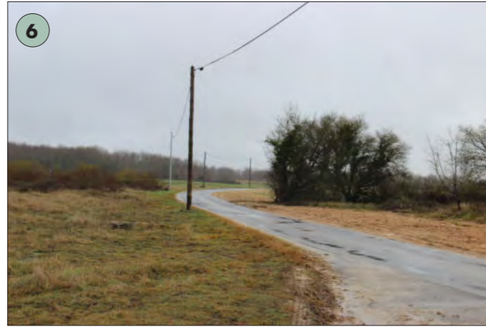
Route communale au coeur du site
