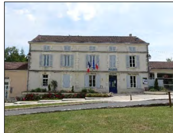
Centre-ville de Mouthiers-sur-Boëme Source : Artifex 2020
