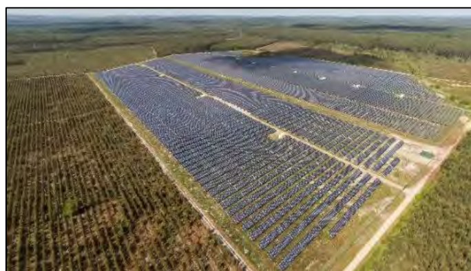
Pompogne (45) : 9,5 MW Source : TSE
